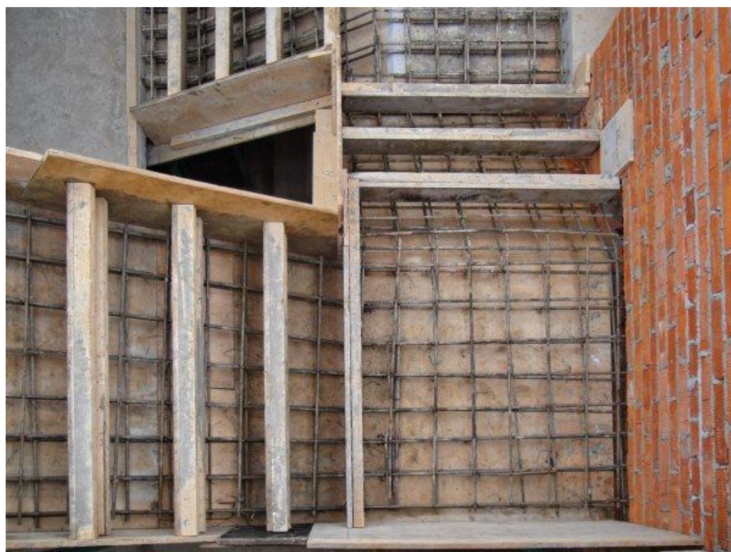
Бетонирование площадки лестницы в кирпичных стенах (вид сверху)
