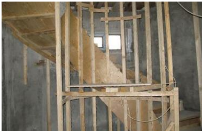
Опалубка для спиральной бетонной лестницы
