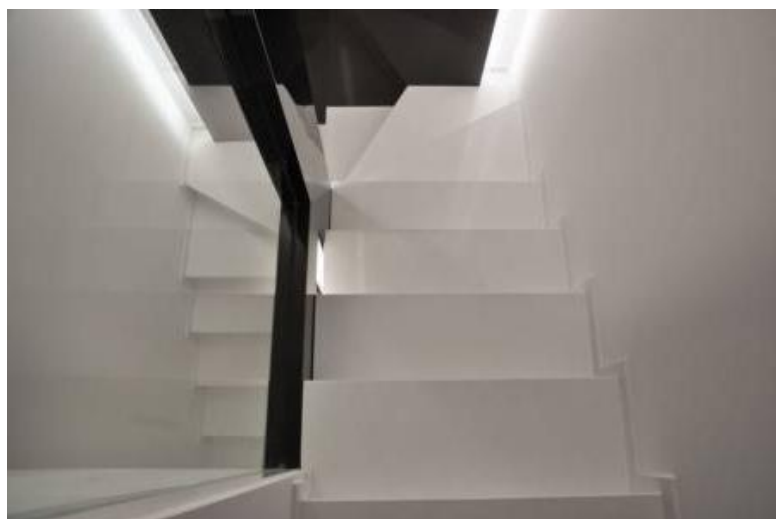
Бетонная лестница между стенами
