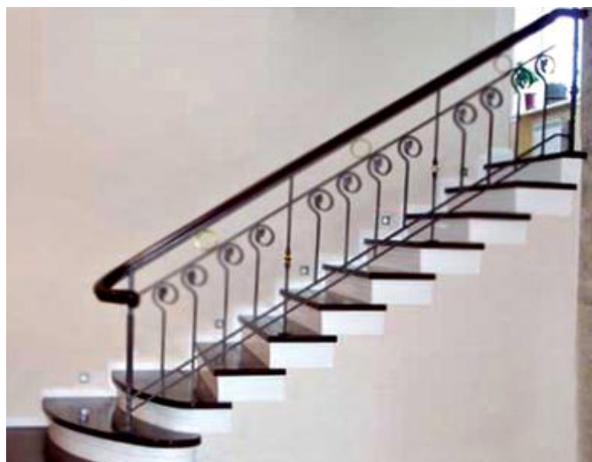
Декоративное оформление одномаршевой бетонной лестницы
