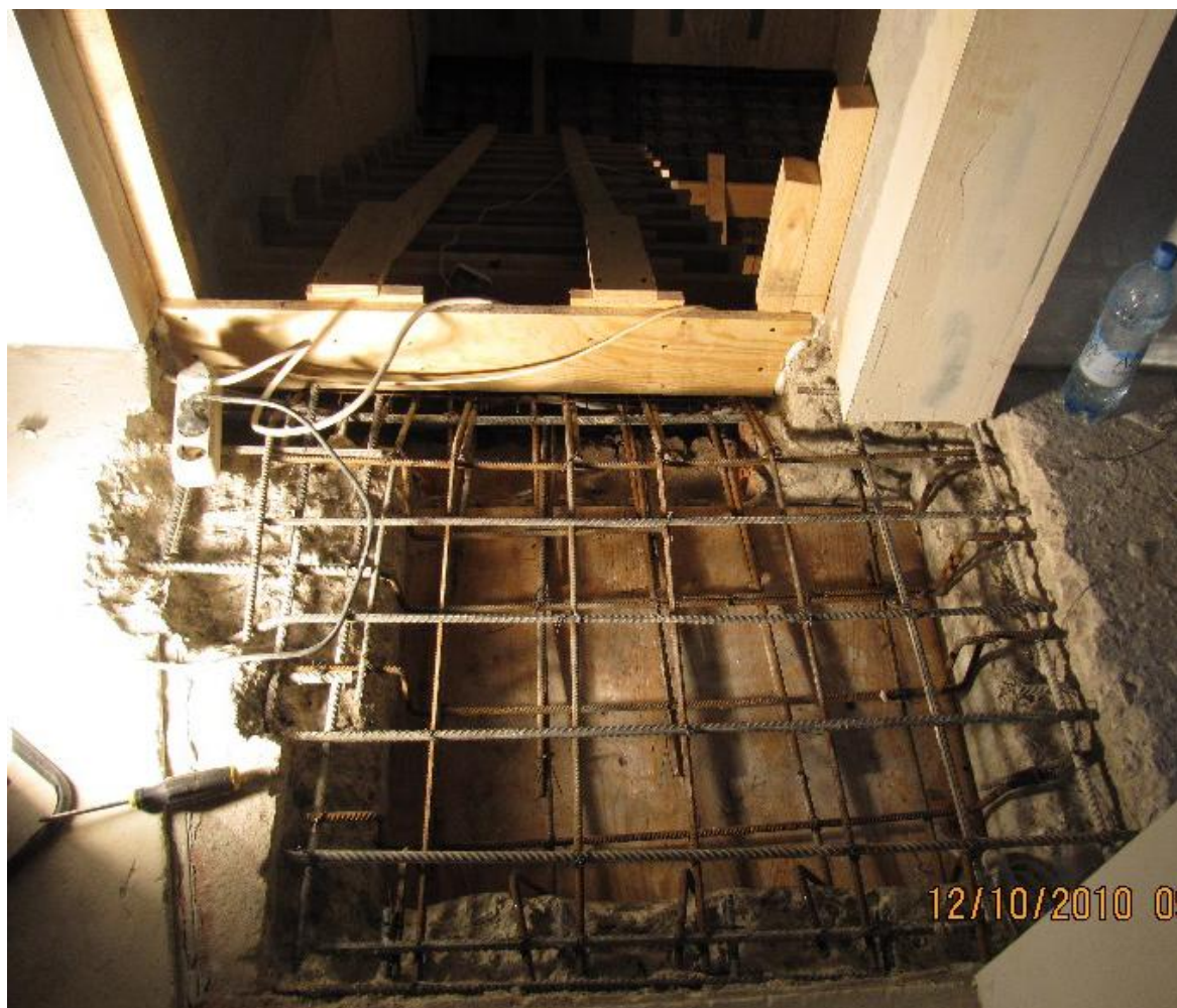
Крепление двухмаршевой лестницы с площадкой сверху к арматурному каркасу
