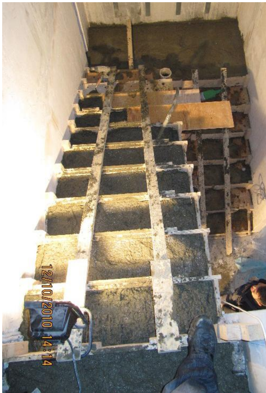
Бетонирование монолитной лестницы
