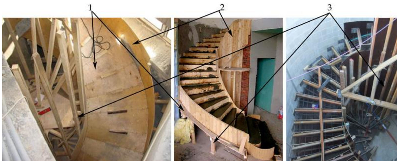
Элементы опалубки для спиральной монолитной лестницы
