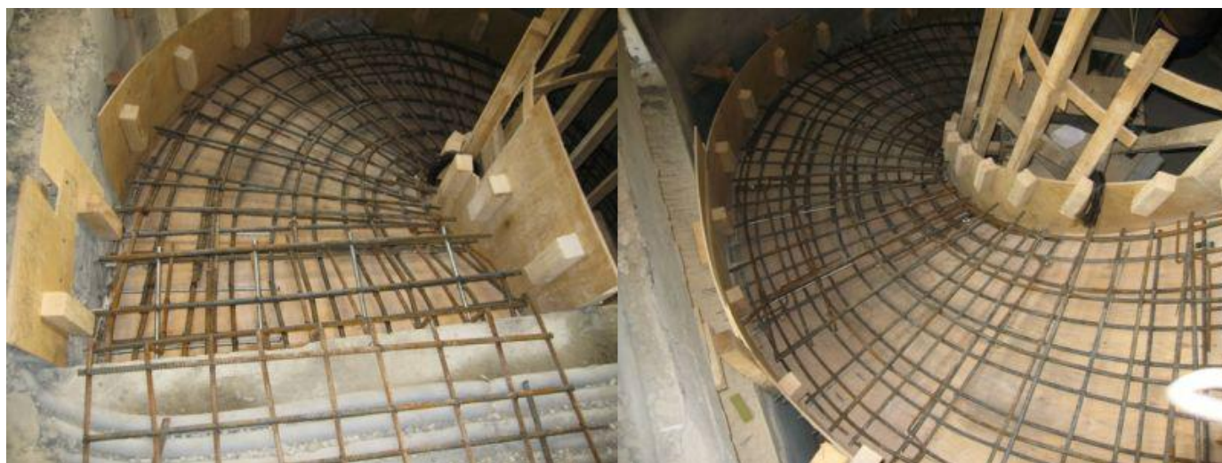
Арматурный каркас монолитной спиральной лестницы
