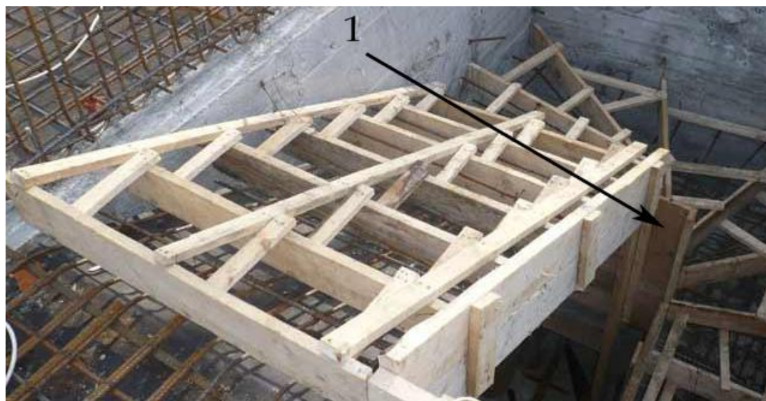
Элементы опалубки для монолитной лестницы с забежными ступенями
