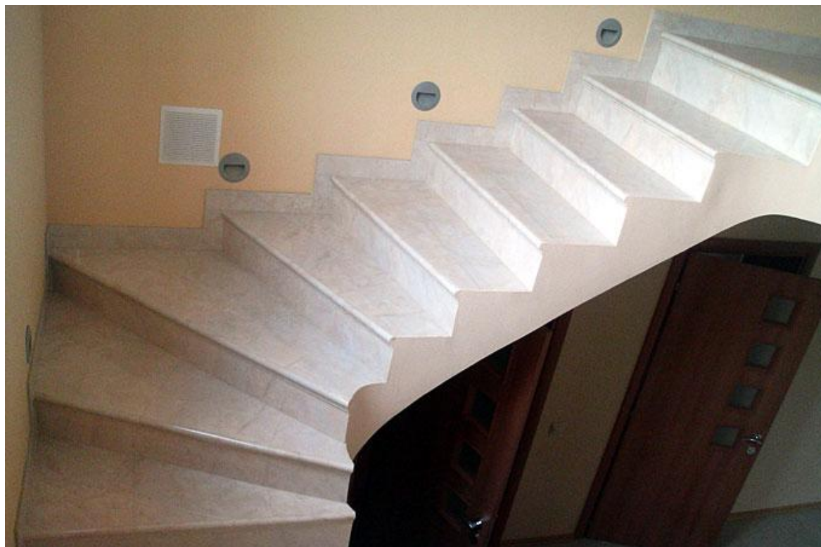
Бетонная лестница с забежными ступенями
