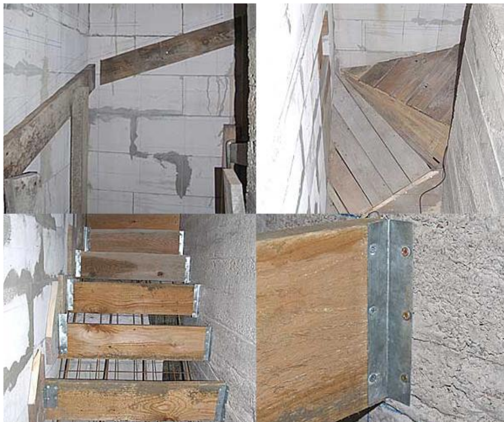
Сборка опалубки своими руками для бетонной лестницы между стенами
