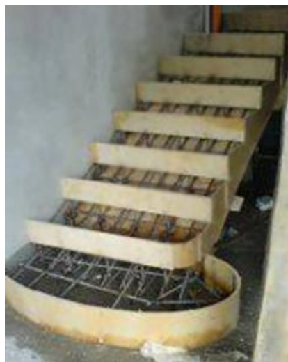
Опалубка для одномаршевой монолитной лестницы
