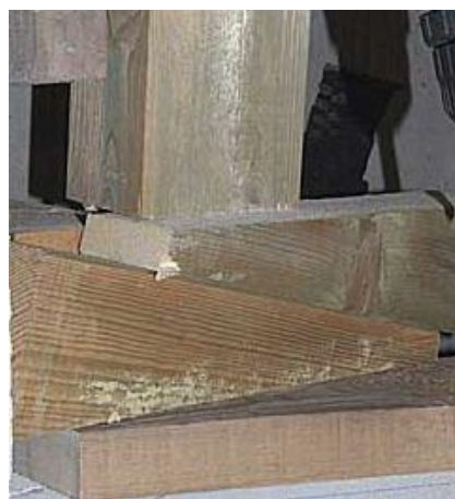
Подпорка стойки опалубки клином
