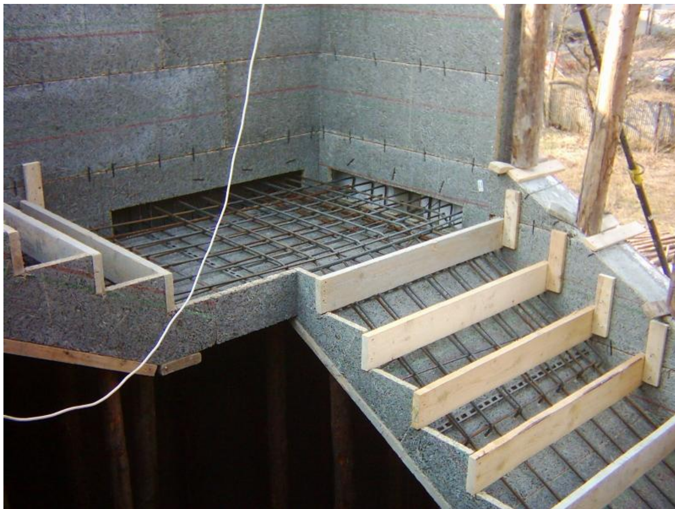
Бетонирование площадки одновременно с бетонированием стен по технологии термом
