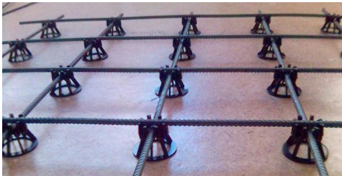
Арматура с пластиковыми фиксаторами
