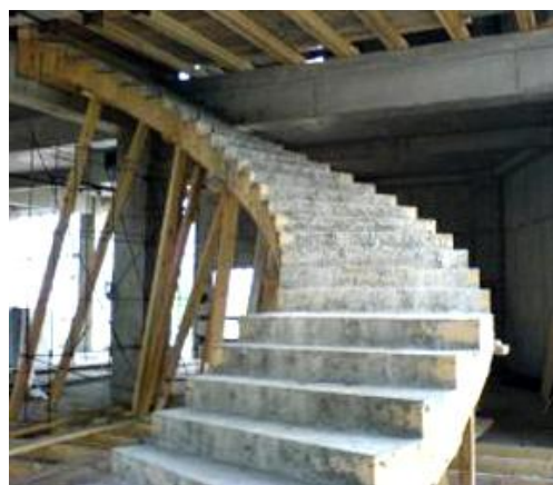
Подпорки под опалубкой для спиральной лестницы
