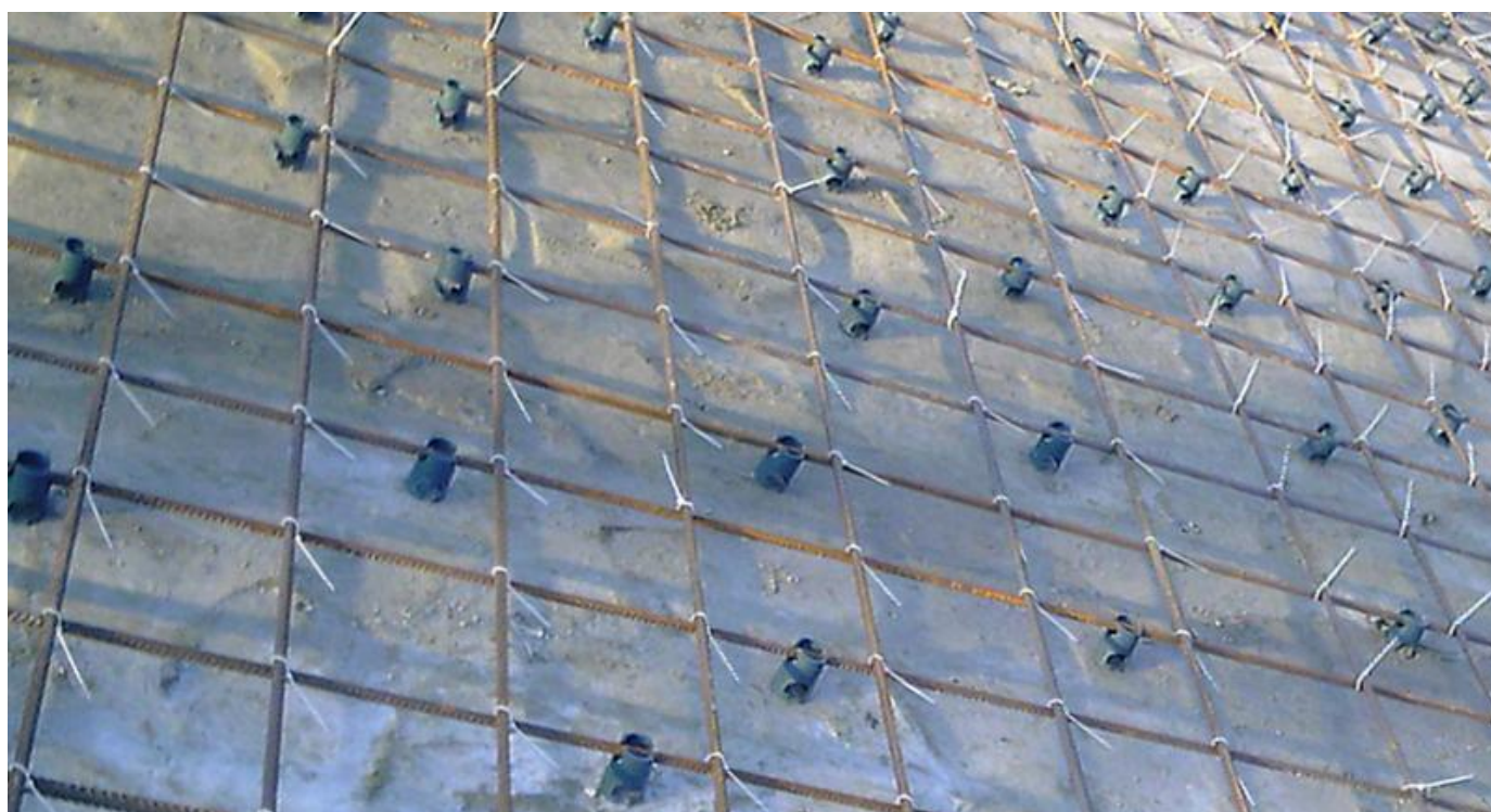
Связка арматуры пластиковыми хомутами
