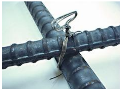
Соединение арматуры связкой проволокой
